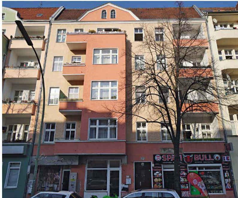
Objekt in Berlin-Neukölln: Reduzierung der Anschlussleistung von 203 kW auf 90 kW, Einsparung der Anschlussleistung : 56 %, Einsparung Grundpreis (brutto) je Jahr: rund 7.100 €
